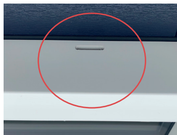
Afbeelding ontwatering sleuf buitenzijde.
