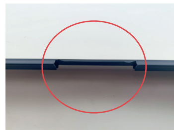
Afbeelding beluchting dmv rubberdichting onderbreking.
