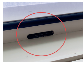
Afbeelding ontwatering sleuf binnenzijde.
